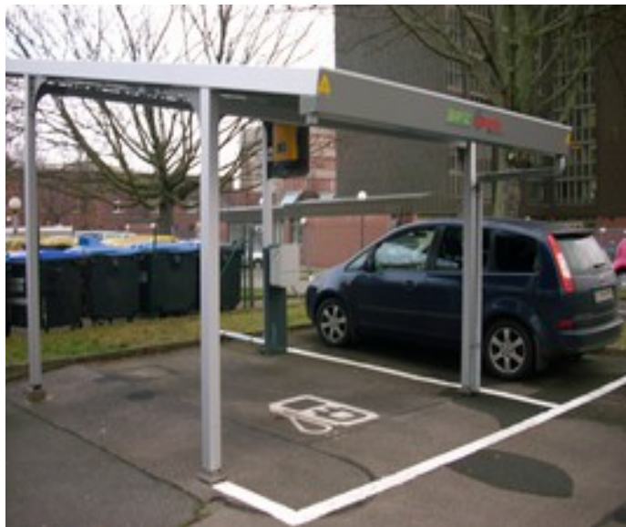
Elektroautoladestelle mit Solardach beim Berliner-Energie- Zentrum
