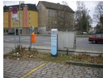
ler S t die Ladestation Am Juliusturm
