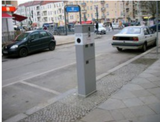
Ladestation U- Bahnhof Vinetastraße
