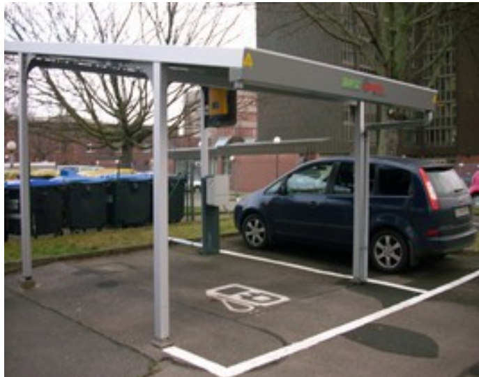
Elektroautoladestelle mit Solardach beim Berliner-Energie-Zentrum
