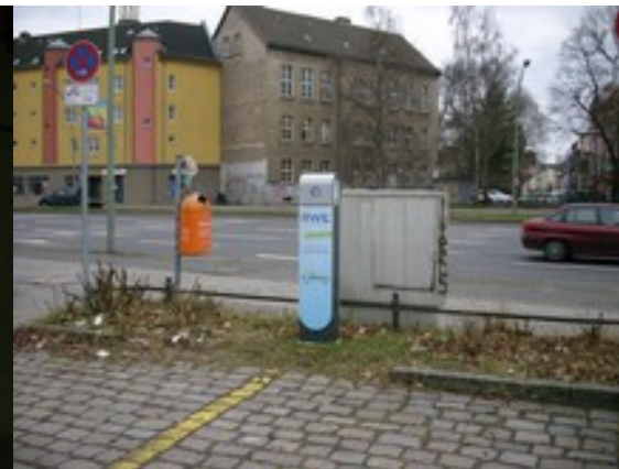
Ladestation Am Juliierturm
