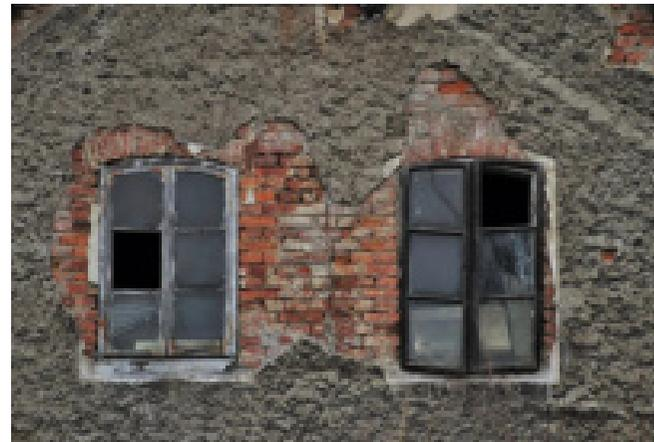
*Ziegelmauerwerk mit Zementputz*
